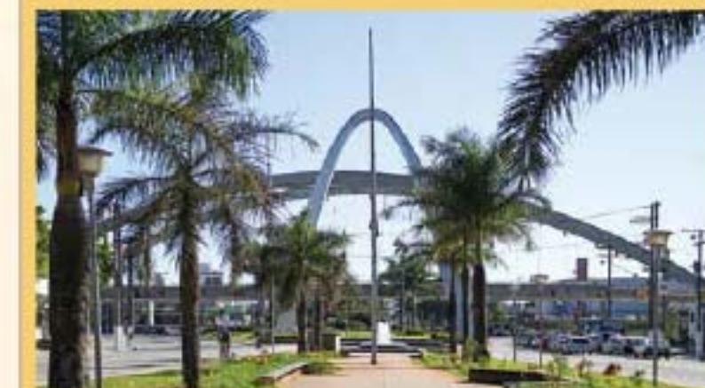
PONTE METÁLICA - VARGEM REYNALDO DE OLIVEIRA
